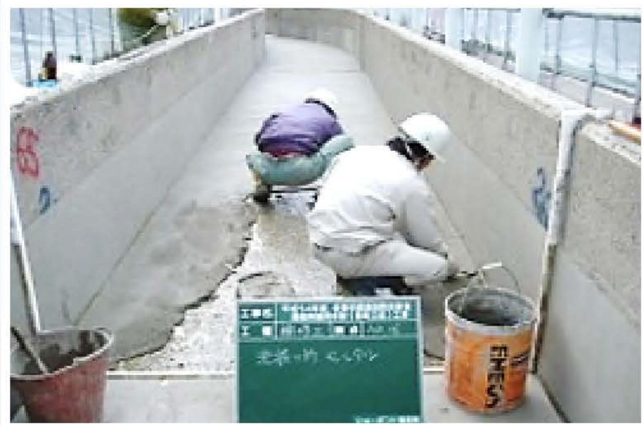
コンクリート等で造成した水路を整備補修することで、水の安定供給を実現しています。
