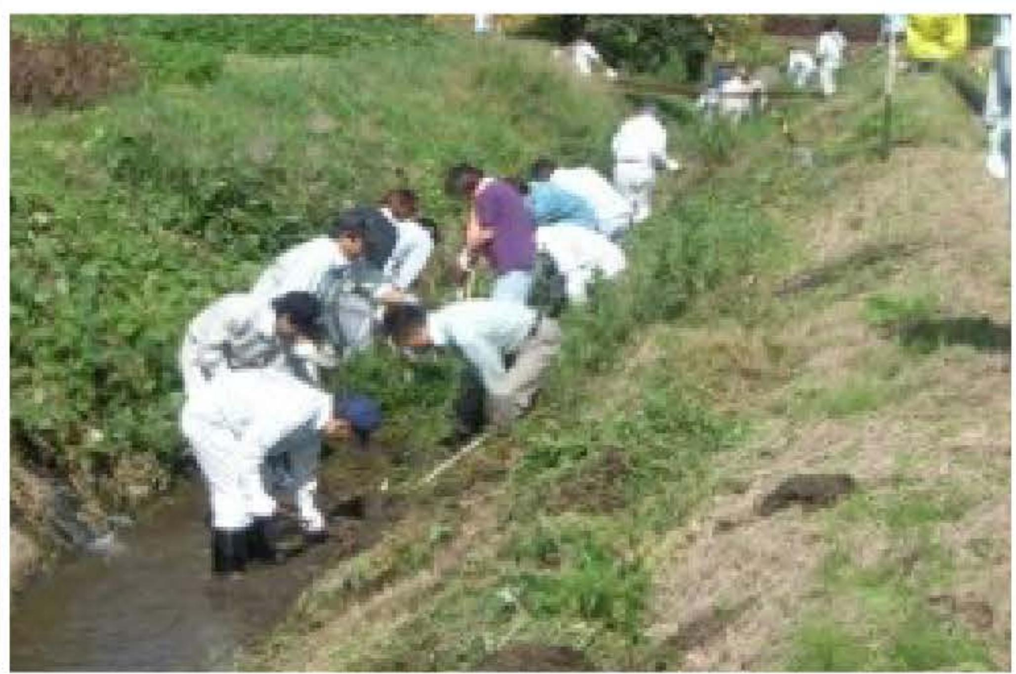
水路の底に堆積した土砂やヘドロを取り除く作業で、通水能力の維持に役立っています。
